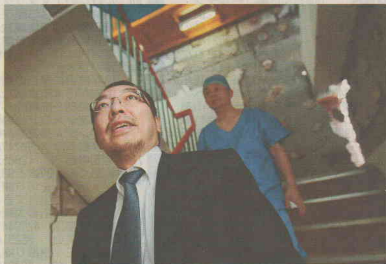
震災で壁が損壊した病院内を見回る服部さん。手術の必要な患者が入院できない非常事態に言葉を失った(17日、福島県郡山市で)＝竹田津敦史撮影
